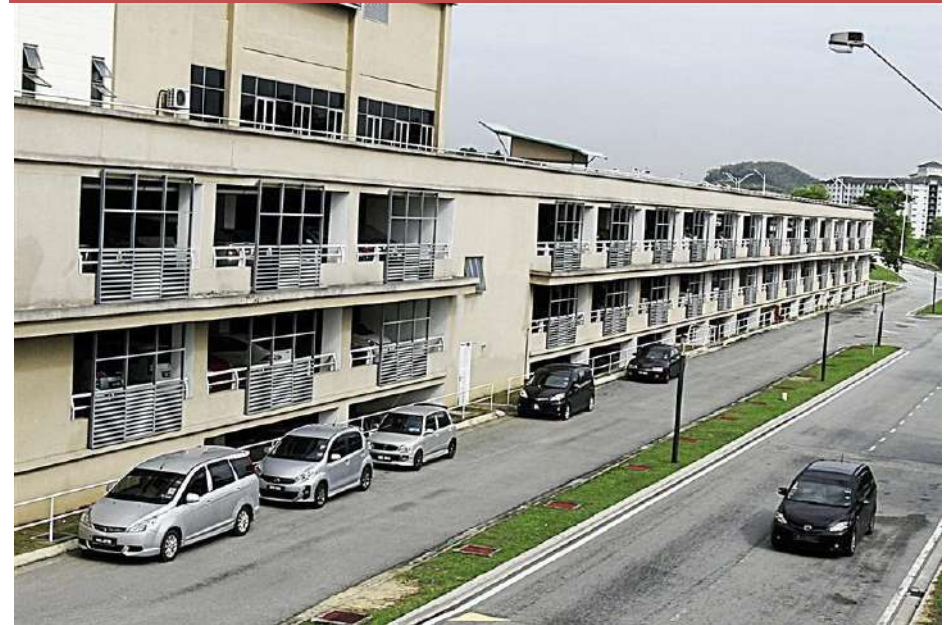
CONTOH BANGUNAN PARK-AND-RIDE DI PERCINT 7, PUTRAJAYA
